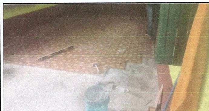
Foto 5: Mejoramiento de piso cerámico
