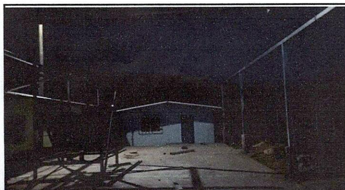
Foto 3: Mejoramiento de techo del patio
