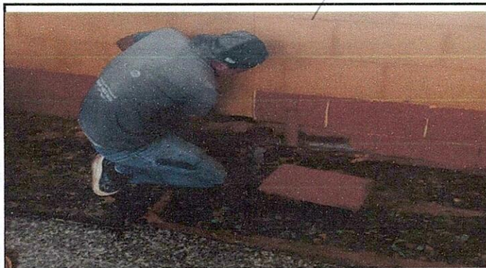
Foto1: Mejoramiento de pintura
